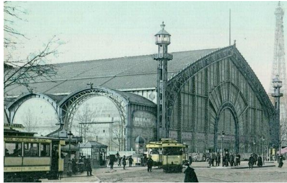
Sl. 29. Galerie des machines, Pariz 1889. Arhitekt Ferdinand Dutret
