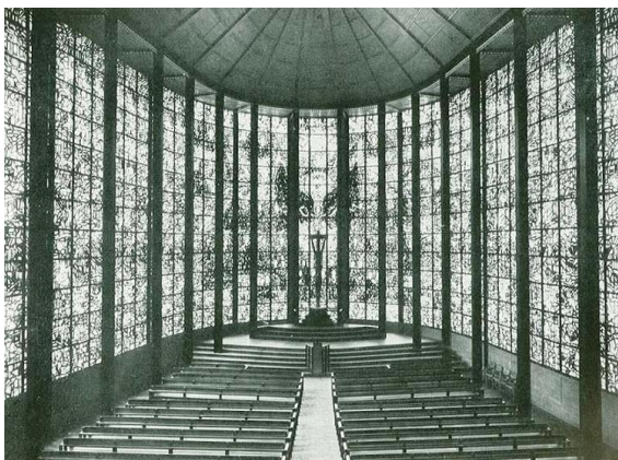
Sl.36. Sthalkirche unutrašnjost Izvor: https://alchetron.com/Otto-Bartning
